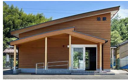
改修後のJR泊駅外観
